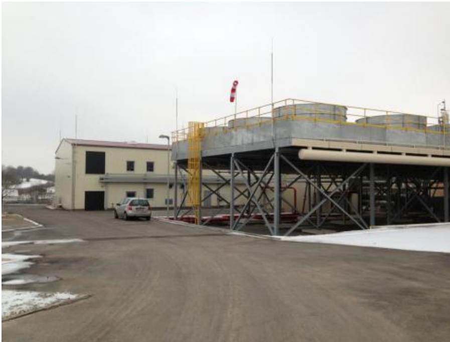
Figura 6. Planta geotérmica en Insheim: ventiladores y edificios de servicios al fondo.
